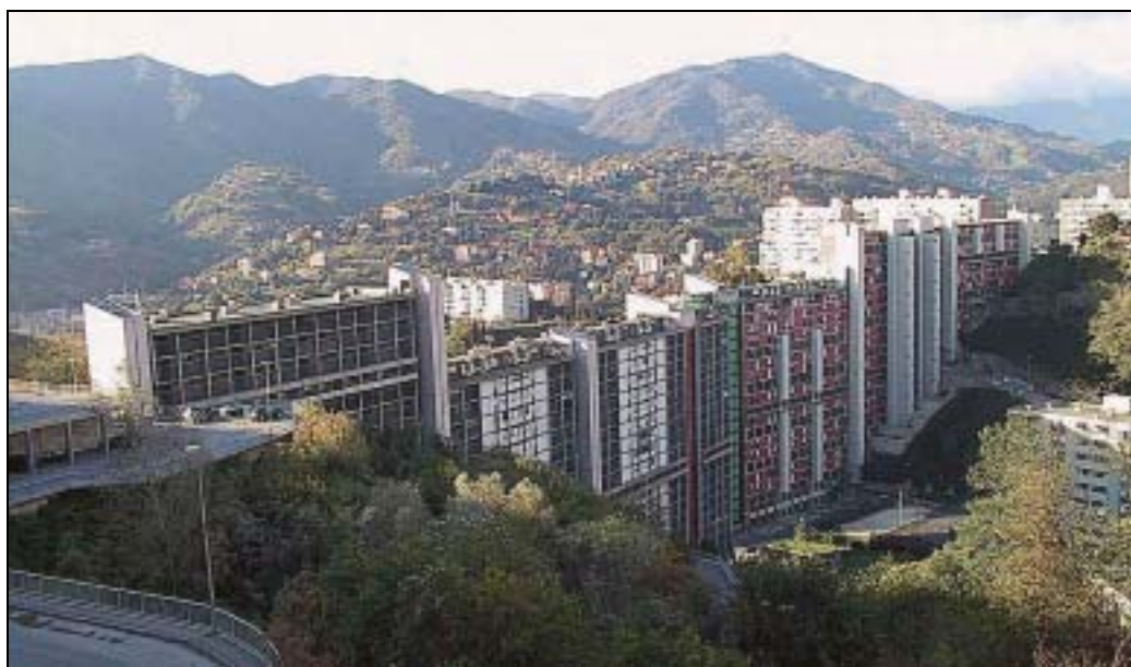
La Diga di Begato: quasi concluso l'intervento di recupero con la "verticalizzazione" del complesso
